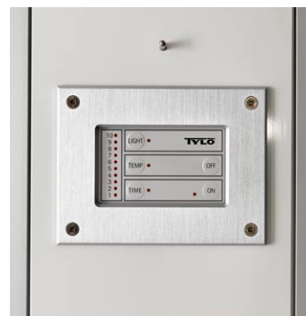
Elektroniczny panel sterujący w części natryskowej kierujący pracą generatora pary.
